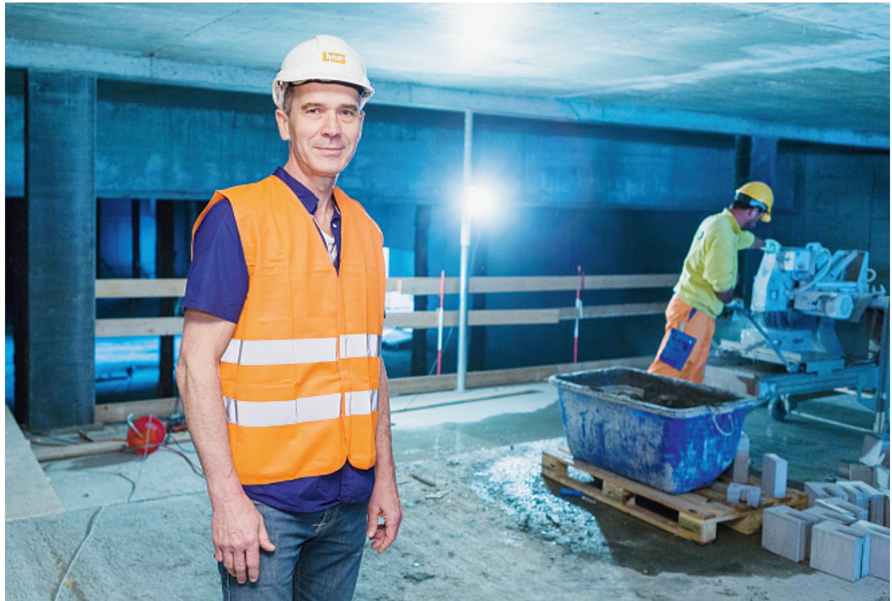
Baustelle: Curlinghallen-AG-Präsident Hermann Vöggtli steht im neuen Restaurant der Curlinghalle. Noch gibt es viel zu tun. Auf und neben den Anlagen am «grünen Tisch».
